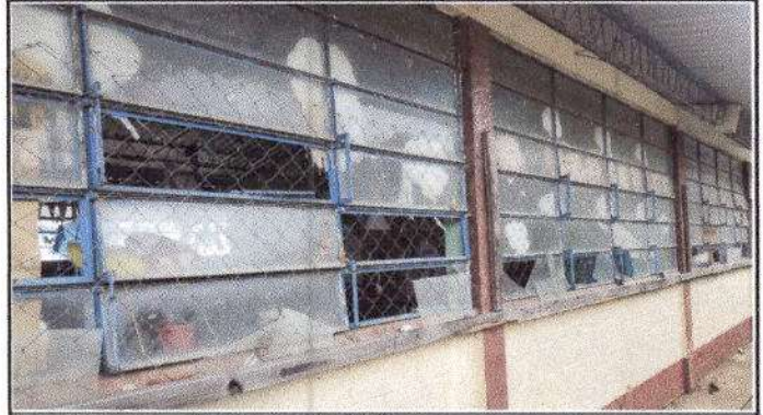
Foto 2: Ventanas-Sustitución de vidrios
