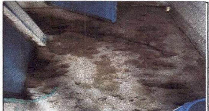
Foto 6: Reparación de Piso de granito
